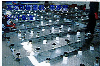
専用支持脚組込型ノズル 取付け状況
