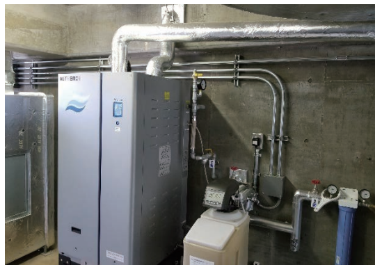
写真④ 設置状態
