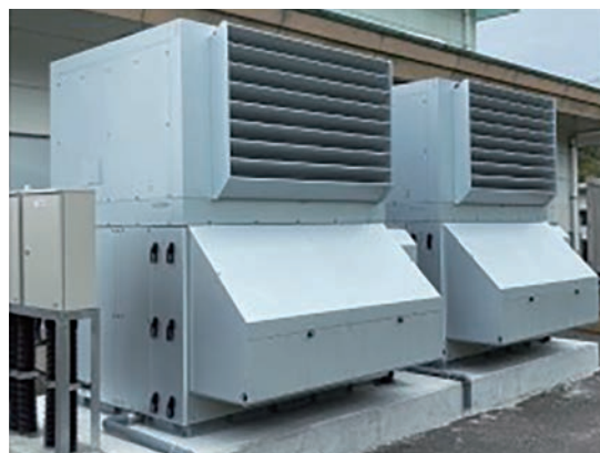
写真3 機器設置例（フィンガード付）
