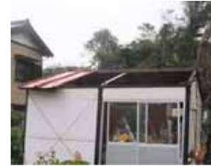
トタン屋根の一部が飛散した プレハブ小屋 (袋井市提供)
