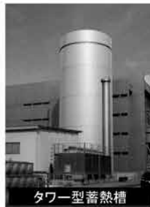
タワー型蓄熱槽
